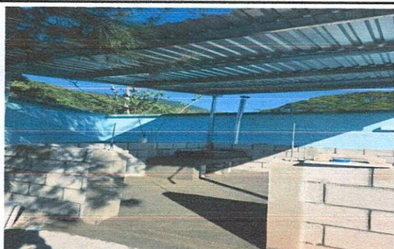
Foto 3: FINALIZACION DE COCINA TIPO PORTICO
